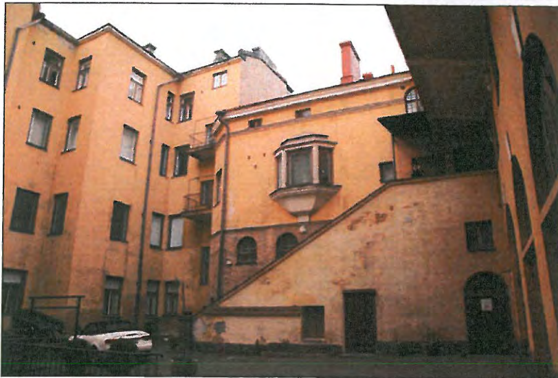
sisäpihan siipirakennuksen julkisivua
